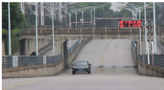
余姚市下立交积水监测显示屏
