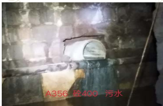
雨水箱涵中混接污水
