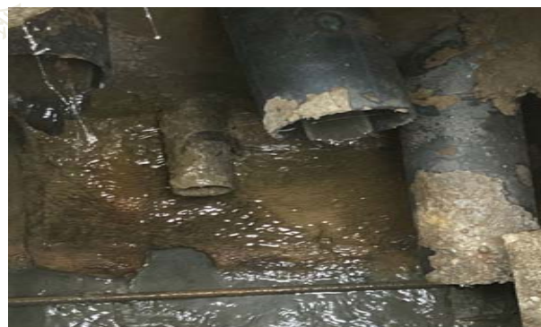
雨水箱涵中混接污水
